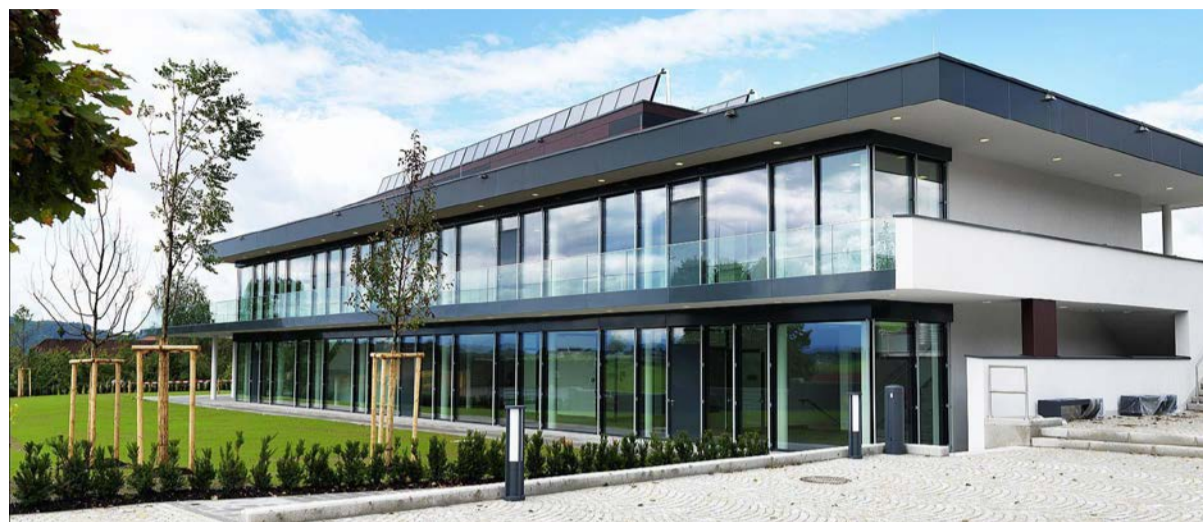
Die Wärmeversorgung des Kultur- und Gemeindezentrums erfolgt ausschließlich über Sonnenenergie.
